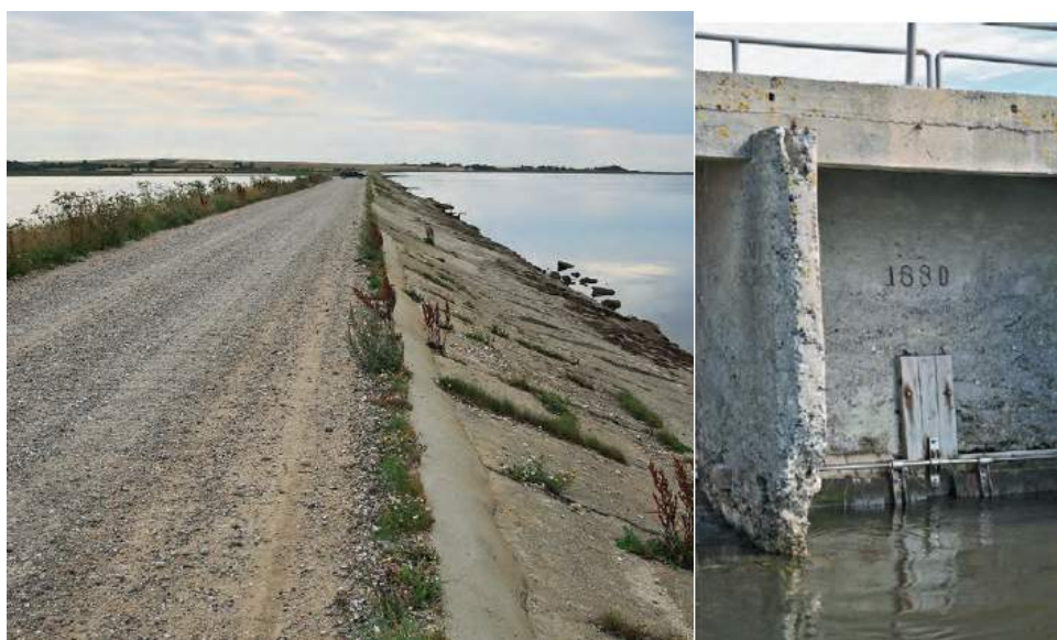
Figur 4-4 Arup-dæmningen og sluse fra 1880 - sluseporten er dog fornyet sidenhen.
