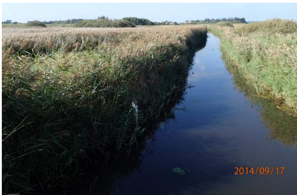
Figur 1-1 Tømmerby Kanal er gravet hele vejen rundt om Tømmerby Fjord med henblik på at kunne kontrollere vandstanden i området.
