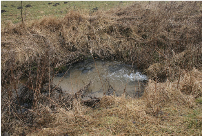
Figur 2 Afløbet fra Hjuldal begynder med et Ø400 mm, der virker som faunaspærring. Den første strækning virker reelt som sandfang.
