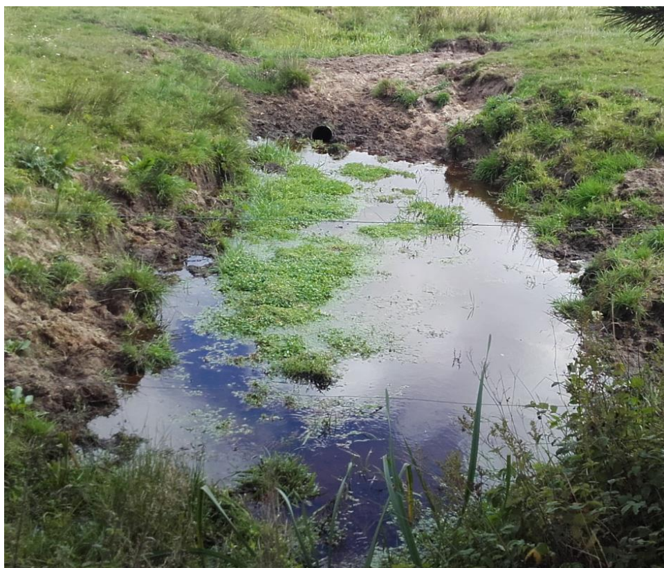
Figur 6-7. Den baljeformede, ny opgravede del af grøften.
