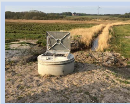
Det færdige højvandslukke.
