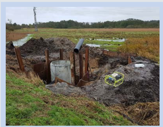
Højvandslukket etableres.
