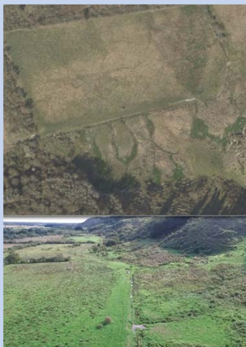
Grøfter ved skræntfoden som afskærer den naturlige udbredelse af vældvand.
