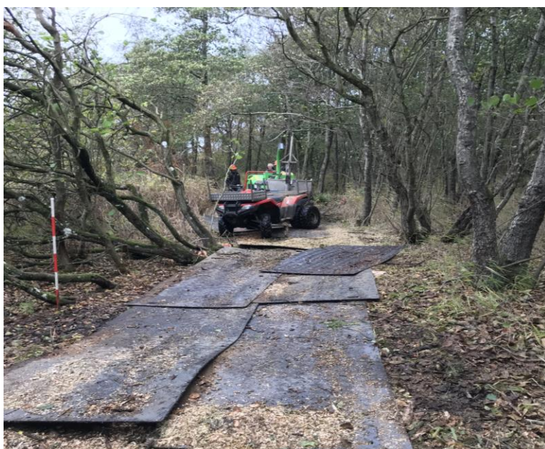
Der er etableret 286 meter trampesti, hvor træer og buske er fældet og knust.
