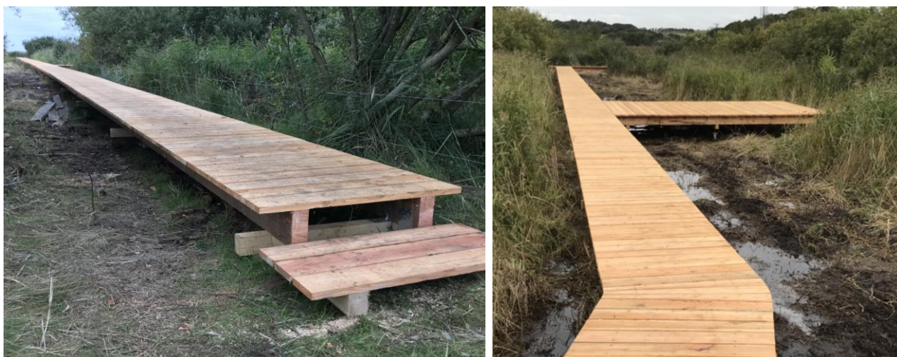
239 meter gangbro er etableret i de vådeste dele af stiforløbet. Dertil er der lavet 20 m 2 platform med hvorfra der er godt overblik over kæret og helt tæt på rigkærsvegetationen.
